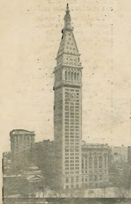
LAS OFICINAS DE "AMÉRICA" EN EL EDIFICIO MÁS ALTO EN EL MUNDO
